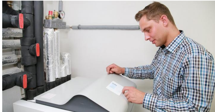
Wärmepumpen könnten Erdgasheizungen verdrängen. (Foto: Bundesverband Wärmepumpe)
