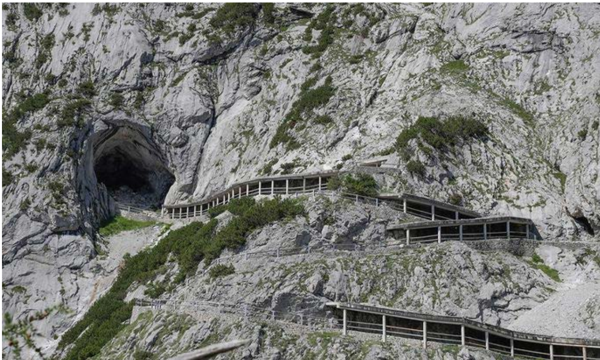
Oberhalb des Zubringerwegs zur Höhle kam es zu dem Felssturz.
