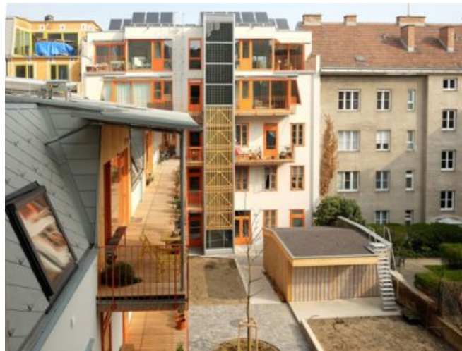
Das Pilotprojekt Geblergasse nach der Wiederherstellung des Innenhofs, unter dem sich Geothermiebohrungen befinden. © Lisi Zeininger
