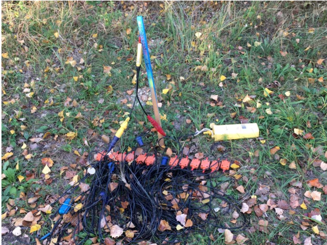
16.000 solcher Messgeräte wurden in Wien installiert
