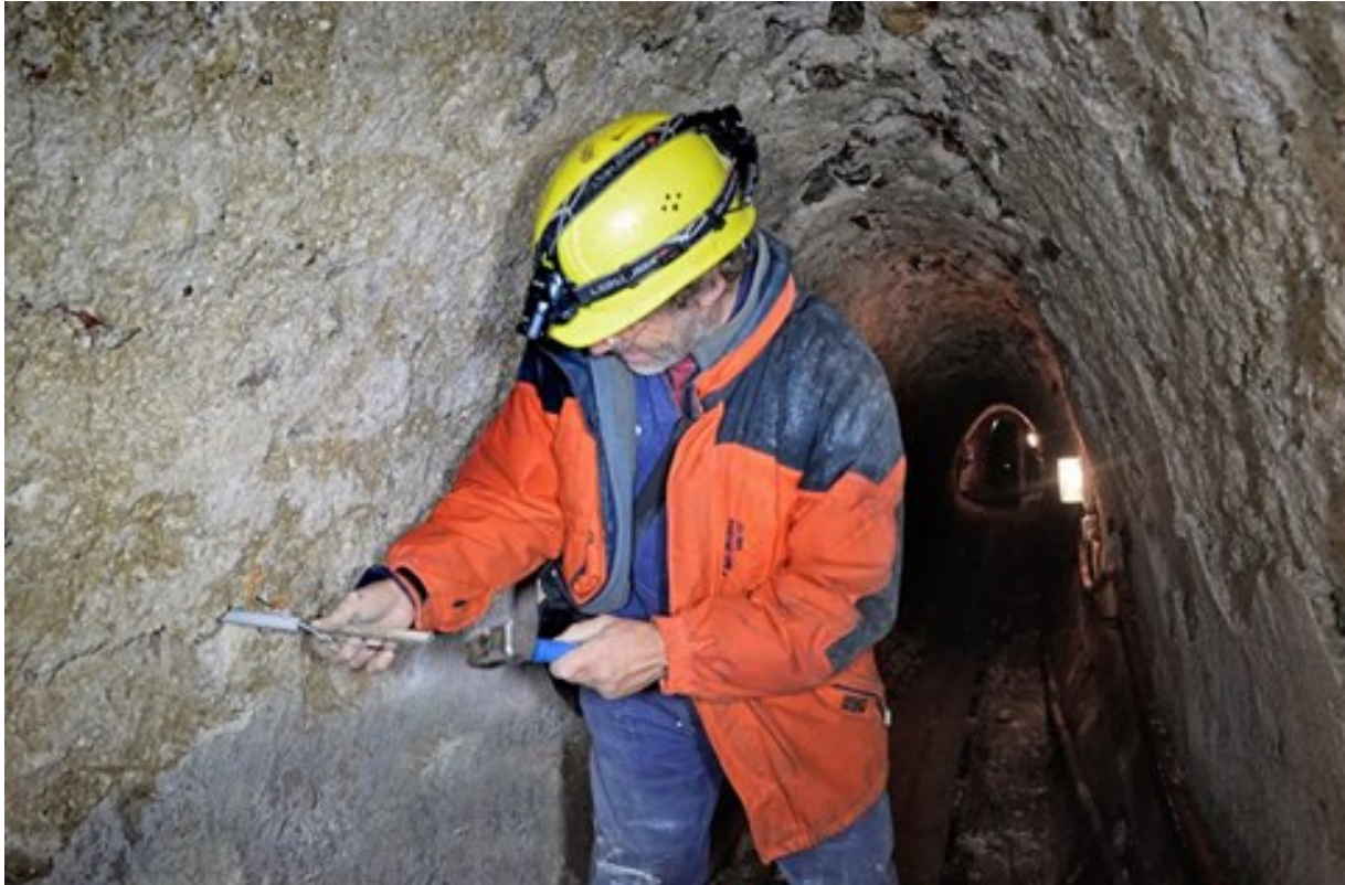
Die Elektroden werden durch die gebohrten Löcher ins Innere des Berges geschlagen. Foto: Daniel Brandner
