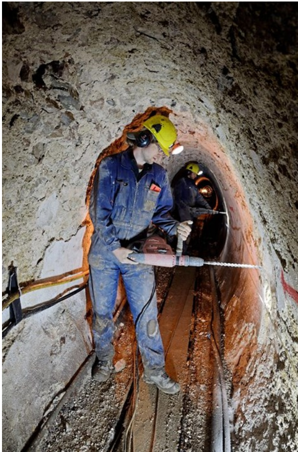
Im Kaiser-Josef-Stollen werden die Löcher gebohrt, in denen die Elektroden versenkt werden. Foto: Daniel Brandner
